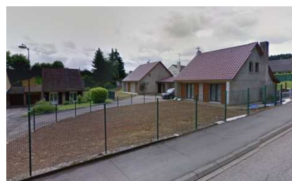
Clôture en grillage
